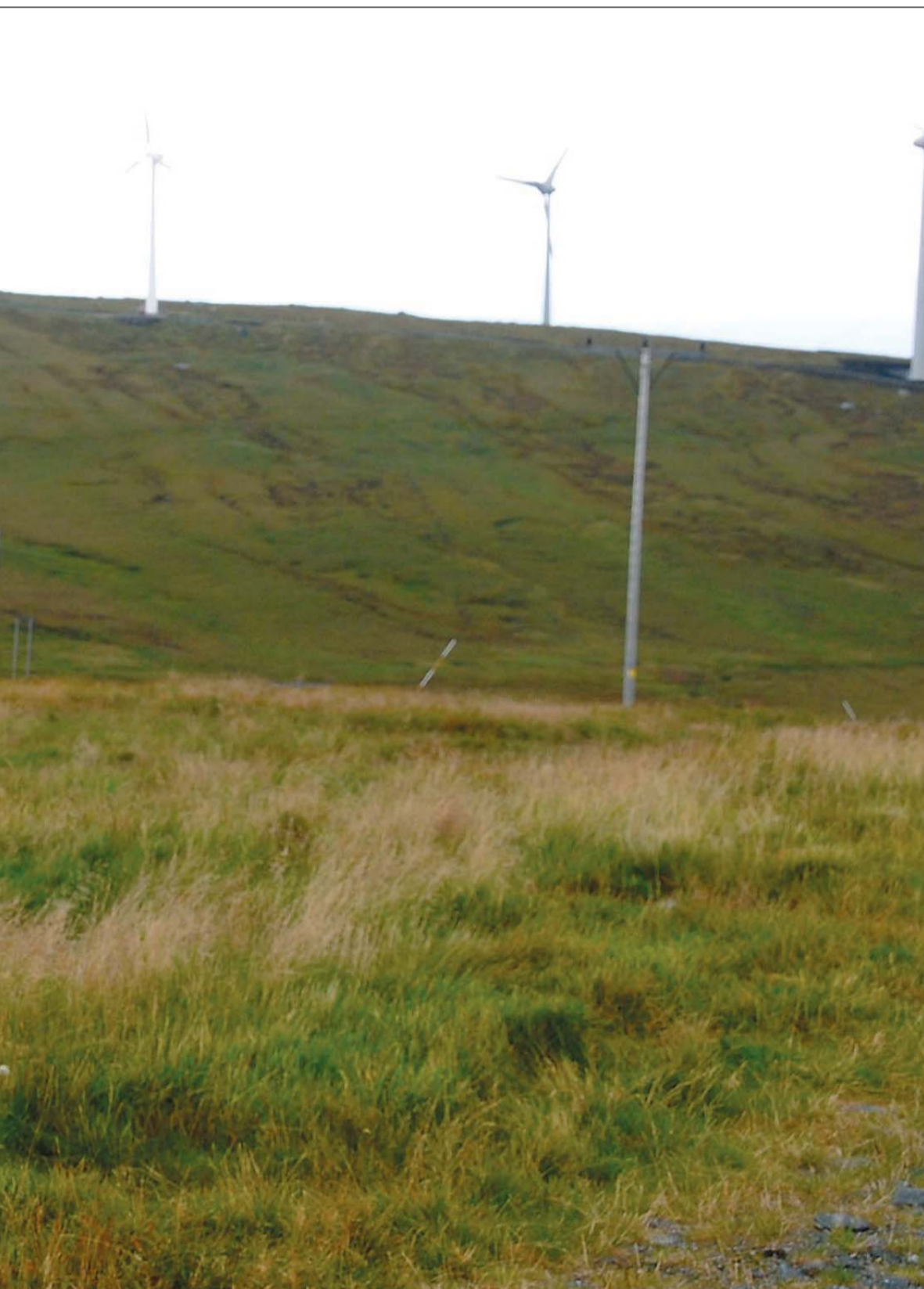
utbygging av vindmølleparkar må først 420kV-linja mellom Fardal og Ørskog byggjast.
